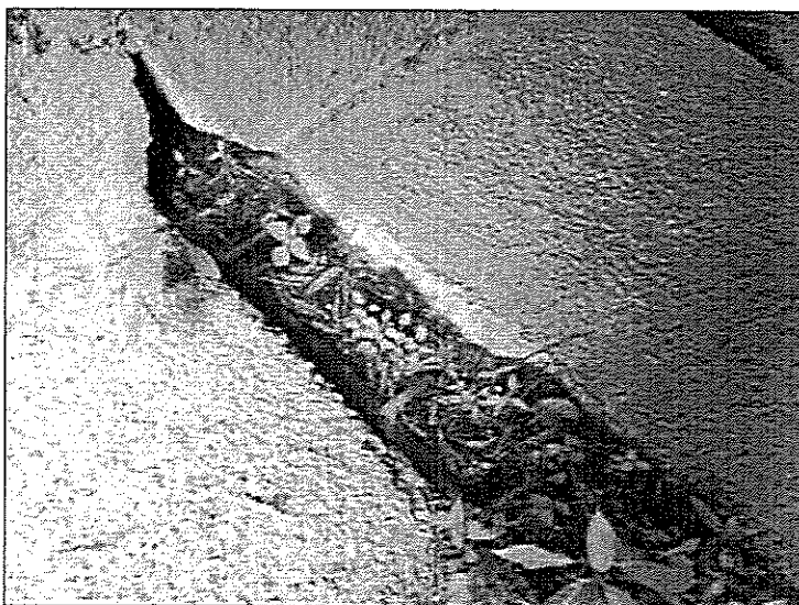
Rozpad dobetonávky mezi prefabrikáty ve dně
